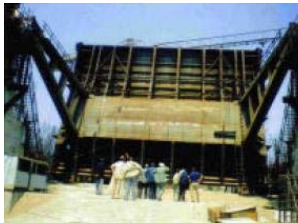
3.2. kép: Szegmens gát építése
