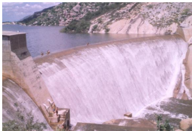
3.2. ábra: Állógát általános elrendezése
