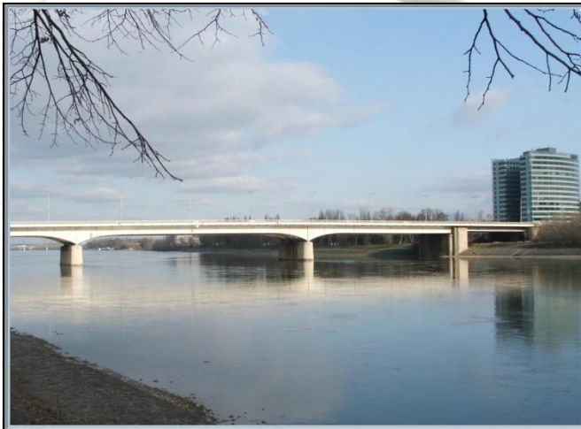
3. kép. Árpád híd - többtámaszú tartó
