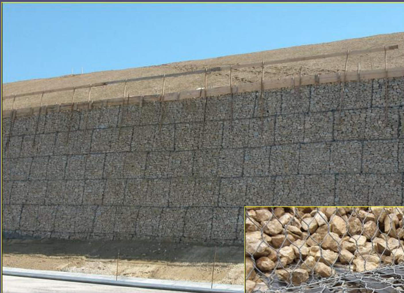
M7 autópálya Bszárszó – Ordacsehi Terra-Mesh támfal Pannon-Freyssinet
