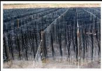
georácsból szerelt geocella
