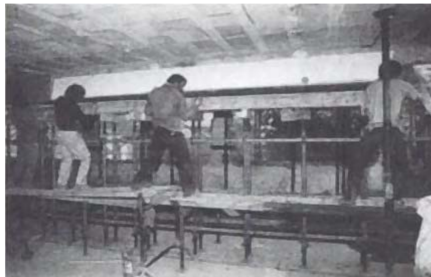
Az acéllemez rögzítése
