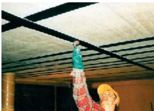
Vasbeton födém megerősítése Sika® CarboDur® lamellával (Sikadur®-30 ragasztó és Sika® CarboDur® lamella)
