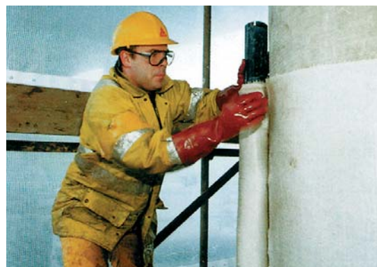
SikaWrap® szövetrendszer alkalmazása oszlop megerősítésére
