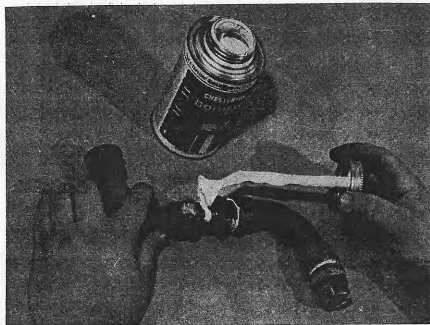
89. ábra. Menettömítés teflonpasztával
