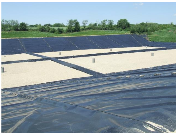
71. ábra: Völgyfeltöltéses hulladéklerakó medencekialakítása
