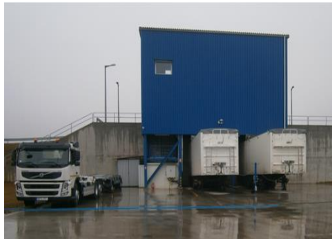
16. ábra: Tömörítés nélküli WF átrakóállomás
