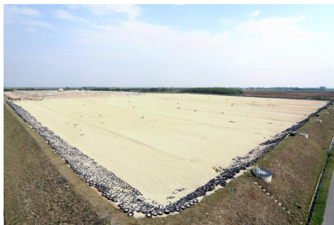
72. ábra: Dombépítéses hulladéklerakó kialakítása
