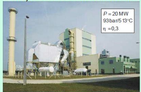
Szakolyi biomassza kondenzációs erőmű
