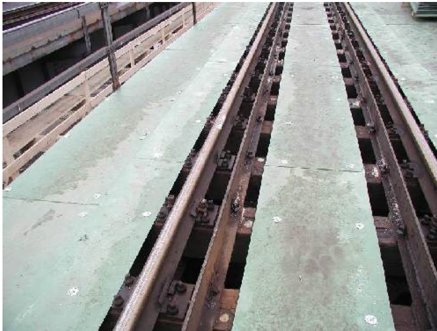
85. ábra Műanyag lemezes vasúti híd
