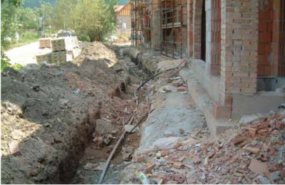
6. fénykép. Építés közbeni felvétel: még nincs szigetelés (a szerző felvétele)
