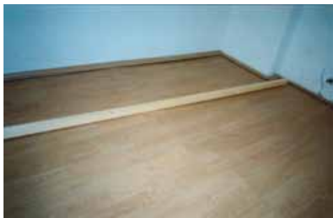
1. fénykép. Laminált padlóburkolat a vízszintes síktól osztályon aluli minősítésű mértékben eltérő, hullámos felülettel
