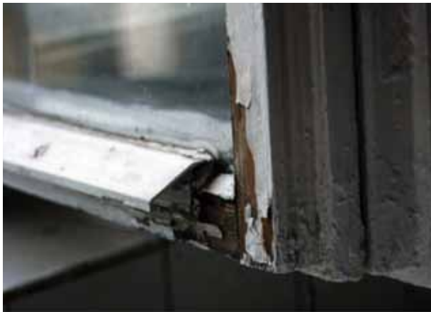
41. fénykép. Teschauer vegyes szerkezetű ablak egy vastag rétegű külső mázolásának tönkremenetele, részben leverődésekkel (fotó: Szende Árpád)
