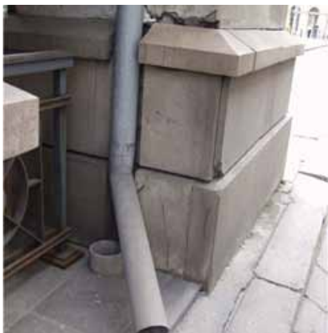
17. fénykép. Lejtések hiánya, hibás ejtőcső-szerelés (fotó: Szende Árpád)
