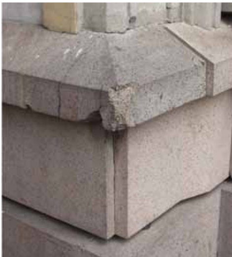
16. fénykép. Hibásan kialakított elem és saroktörés (fotó: Szende Árpád)
