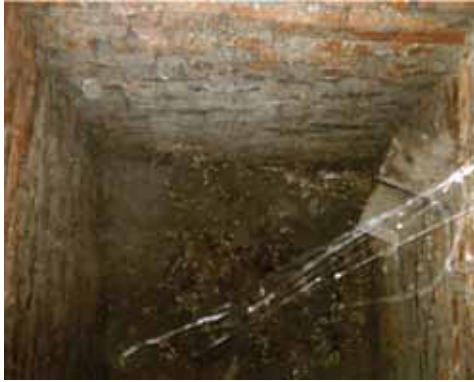
5. fénykép. Téglafalazatú szikkasztóakna
