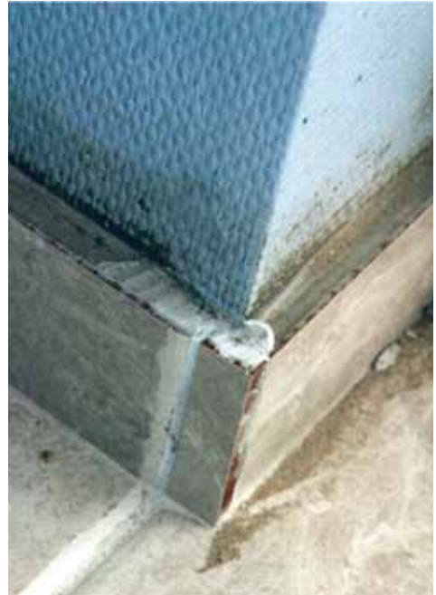
38. fénykép. Az üvegfonat-tapétázást és belső műanyagfestést követő lábamatburkolati munkák okozta meghibásodás nézete (fotó: Szende Árpád)
