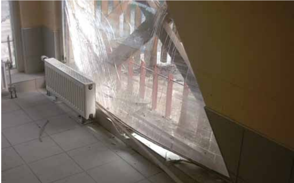
2. fénykép. Víznyomás által benyomott biztonsági üvegtábla
