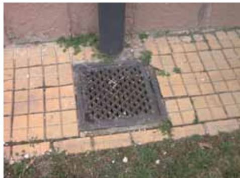
8. fénykép. Az eresz-lefolyócsatorna vas állványcsőhöz csatlakozik, az állványcső mellett a járdában mindenütt öntöttvas rácsleppal fedett nyílás látható, mely önmagában is vízgyűjtőként működik a lábazati fal mellett
