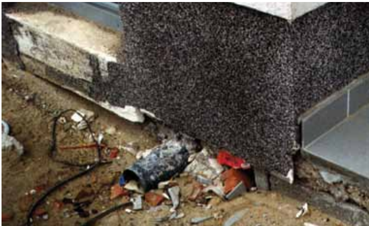
39. fénykép. A homlokzaton lévő lábmat vékonyvakolat és hőszigetelésének hibái, a burkolat (lépcső) hiányai, hibája, és az utólagos épületgépészeti és épületvillamossági átvezetések miatt (fotó: Szende Árpád)
