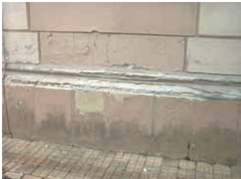
13–14. fénykép. Lábazat és járda csatlakozása
