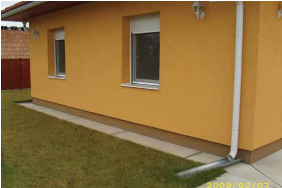
9. fénykép. A járda szintje alacsonyabb a terepszintnél, és közel azonos a belső padlószigetelés síkjával (fotó: TE)
