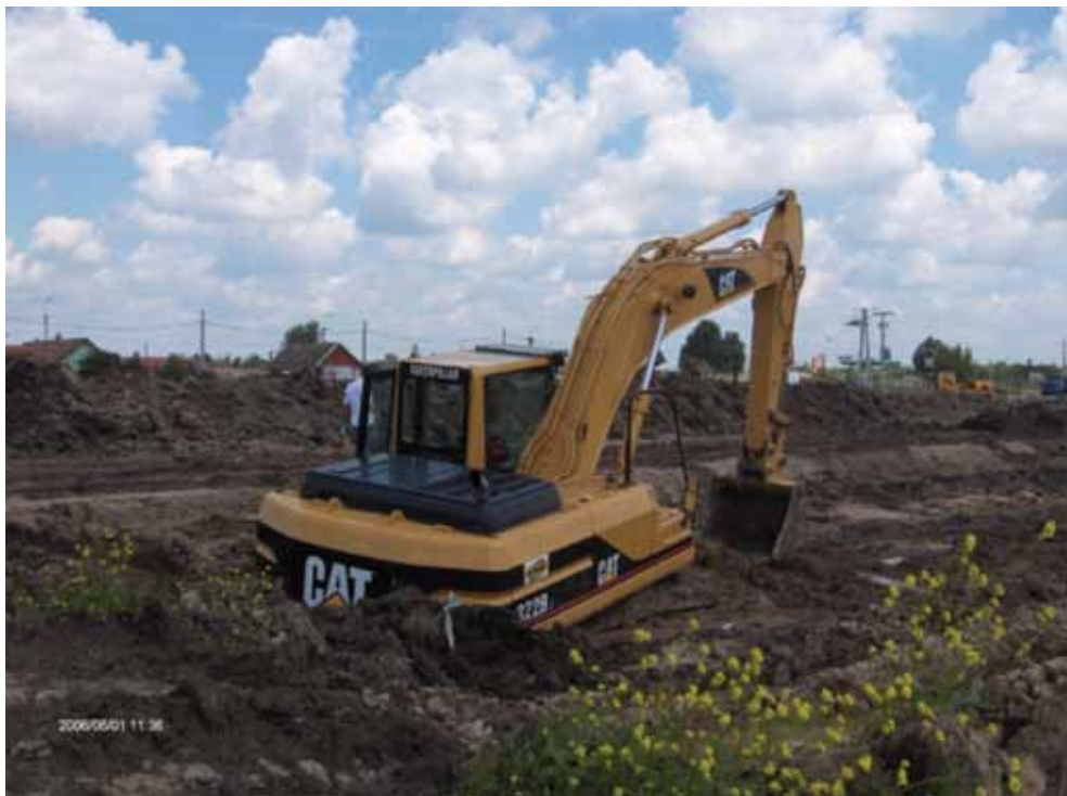
3. fénykép. Lánctalpas kotrógép, elmerülve a sárban a munkaterületen. 2006. 06. 01.
