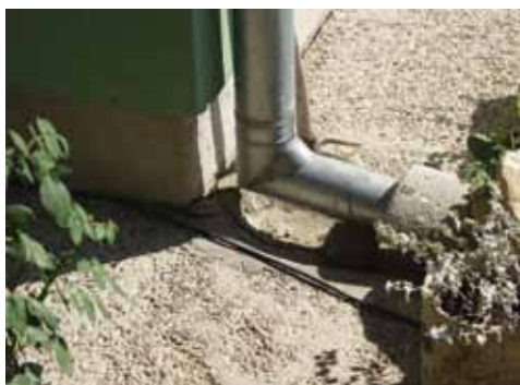
5–6. fénykép. A lefolyócső kifolyójának eleje és vége
