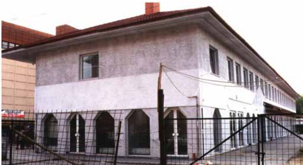
8. fénykép. Az emeleti hőszigetelő vakolat helyett részben hagyományos homlokzatvakolat készült (fotó: Szende Árpád)
