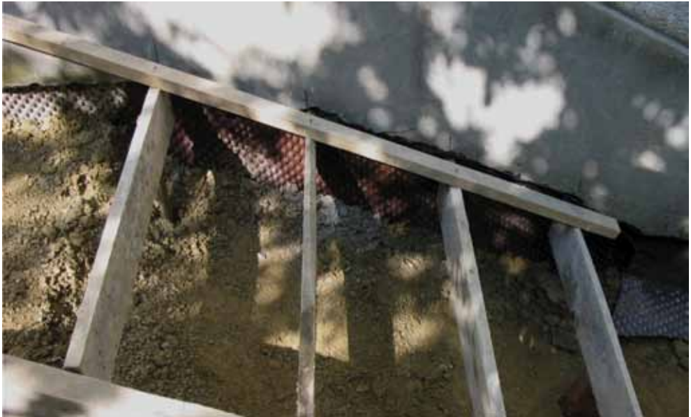
5. fénykép. A szigetelt függőleges lábazat dombornyomott védőlemezzel. Előtérben a délnyugati homlokzat déli sarok felőli szakaszának járda- és lépcsőszaluzata. Jól megfigyelhető, hogy az elkészítendő betonozás aljzata a helyszíni gyengén tömörített agyagos talaj. Szivárgó réteg, kavicságyazat nem készült. (A felperes felvétele 2005. 04. 27-én)
