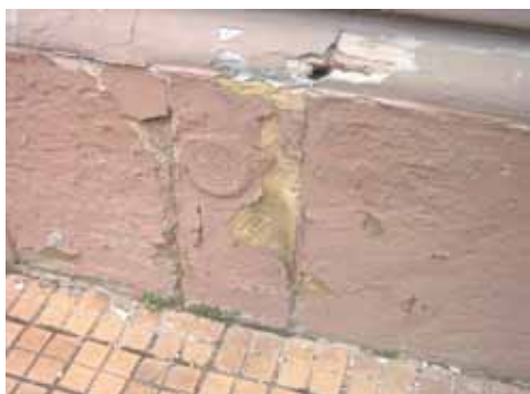
9. fénykép. Lábazat és járda csatlakozása
