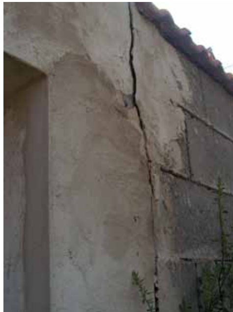
10. fénykép. A pince- (garázs-) fal és a „támfal” közötti elválasztás azok önálló mozgásához (a fal kidőléséhez) vezet.
