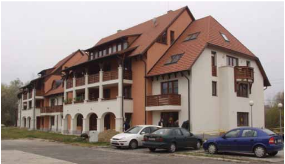
2. fénykép. Az épület kert felőli nézete ÉNY felől
