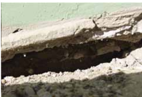
3–4. fénykép. A garázs fala alatti alap-, vízszigetelés 1. jelű feltárása, valamint lábázat és járda hiánya
