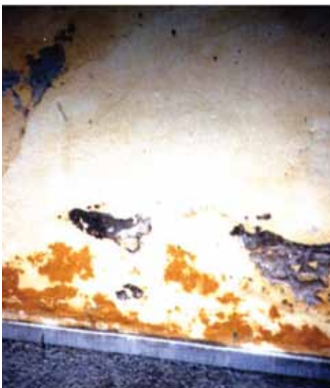
16. fénykép. A homlokzatvakolat részleges tönkremenetele a falzatban lévő oldott sótartalom és nedvesség miatt (fotó: Szende Árpád)
