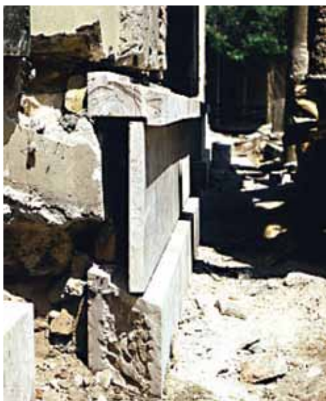
4–5. fénykép. Építés közbeni „metszet”, és sarokképzés nézete a Császárfürdő homlokzatán
