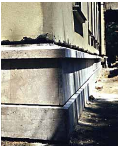
4–5. fénykép. Építés közbeni „metszet”, és sarokképzés nézete a Császárfürdő homlokzatán
