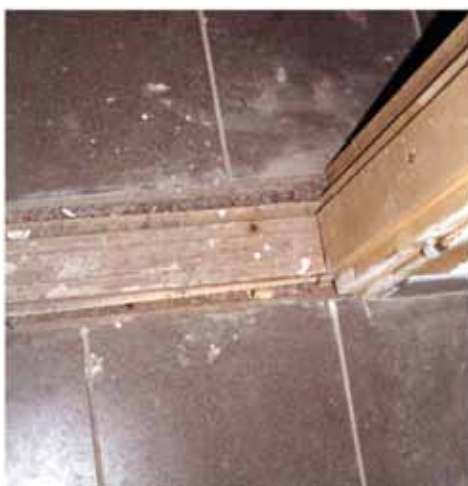
17. fénykép. Fa ajtó sérülés és más anyagokkal való összekent volta miatt mázolásra nem alkalmas fogadószerkezet felületének nézete (fotó: Szende Árpád)
