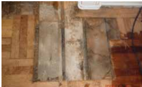
3. fénykép. Régi parketta és a rákerülő laminált padló részlegesen elbontva a radiátor közelében jelentős nedvességfoltokkal
