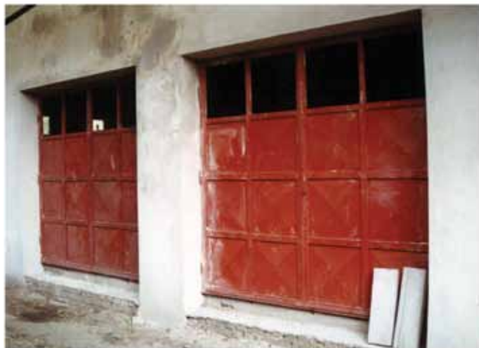
2. fénykép. A mázolás munkája nem készült el, hiszen az alpmázolás a lakatosmunkához, a műhelykész állapothoz tartozik (fotó: Szende Árpád)
