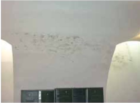
15–16. fénykép. Külső fali boltváll és parapetfal nedvesedése
