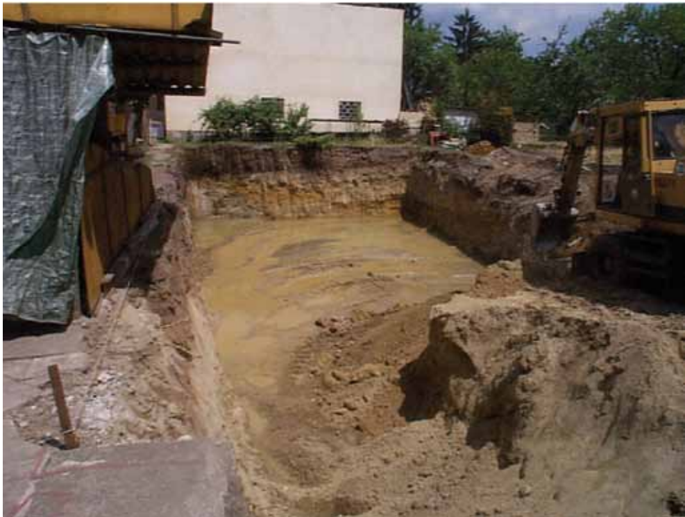
1. fénykép. Pincegödör-földkiemelés függőleges földfalakkal (fotó: az építtető)
