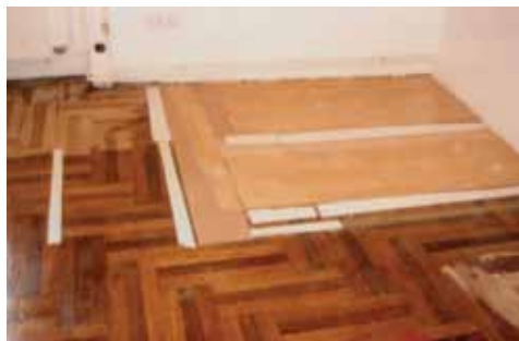
2. fénykép. Laminált padlóburkolat az eredeti halszálkamintás parkettafelületen, a régi parketta felületének síkbeli kiegyenlítése érdekében alátét-csíkokkal alátámasztva
