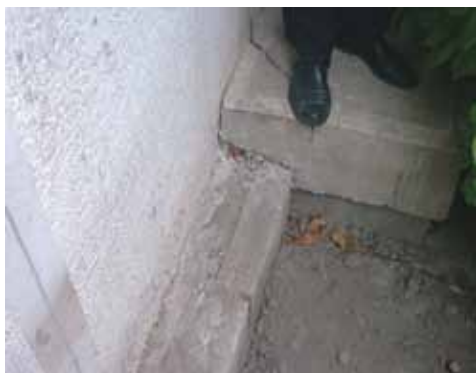
11. fénykép. A pince vízszigetelésének felső lezárása a lépcsőnél
