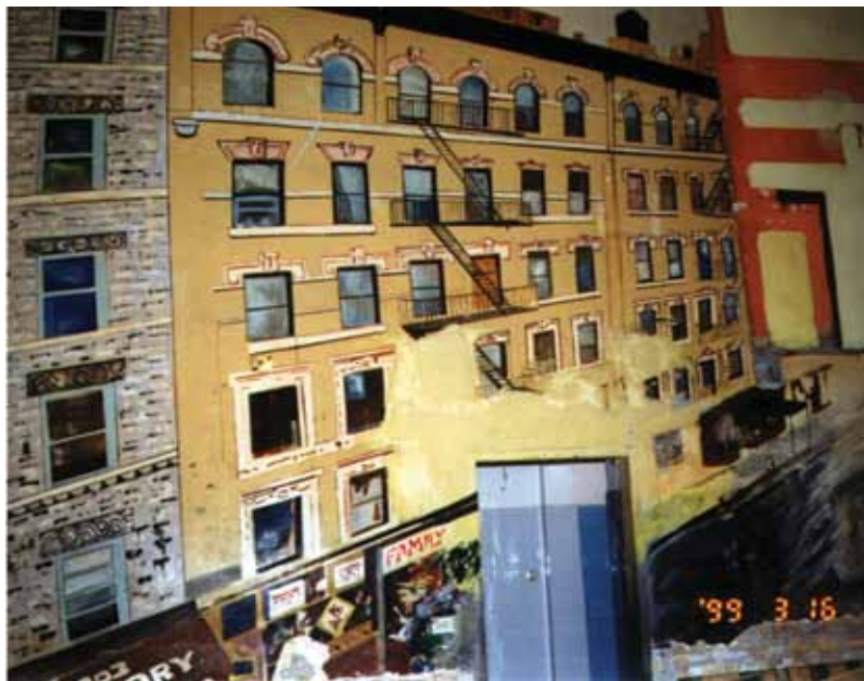
45. fénykép. Falfestményt tartalmazó falba utólag „szépen” kijavítva és mázolva beépített acél kétszárnyú ajtó (fotó: Szende Árpád)
