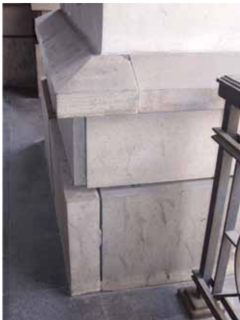
27. fénykép. Megengedtnél nagyobb hézagszélesség (fotó: Szende Árpád)
