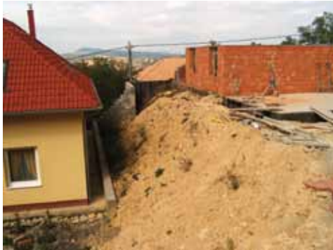
11. fénykép. Átgondolatlan tereprendezés és vízvezetés
