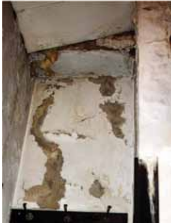
23. fénykép. Belső mészfestés leveles leválásának, lepergésének hibája (fotó: Szende Árpád)
