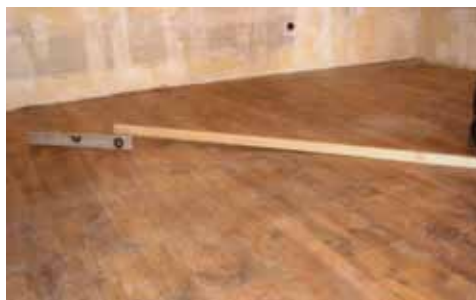
6. fénykép. Laminált parkettafelület, több cm nagyságrendű eltéréssel a vízszintes síktól
