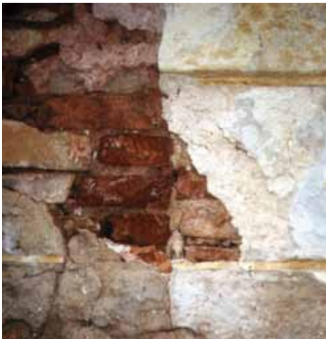
19. fénykép. Átnedvesedett és be nem kötött különböző korú, anyagú falazatokra került homlokzati vakolat meghibásodása (fotó: Szende Árpád)
