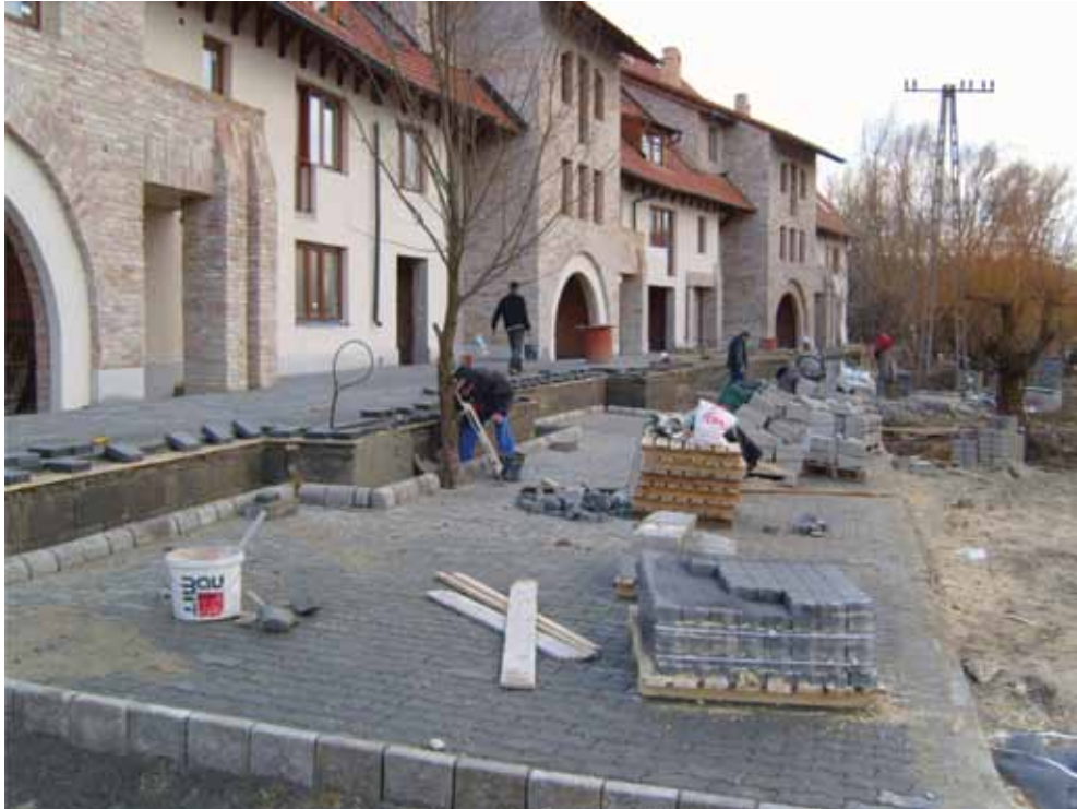
7. fénykép. Építés közbeni felvétel: a földszinti teraszok alatt – előtt nincs szigetelés, de a végső felületképzés készül (a szerző felvétele)
