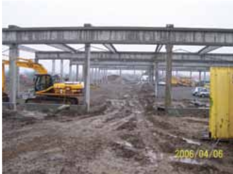
9. fénykép. Csarnoképítés talajvízben. 2006. 04. 06.
