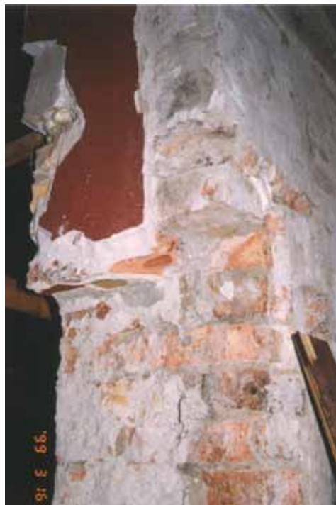
49. fénykép. A „Tilos az Á” szórakozóhely első tulajdonosa elvéste-bontotta a boltvállat, mely munkamenet „korát” a rávakolt felület azonos vörösarna festésének megmaradása igazolta (fotó: Szende Árpád)
