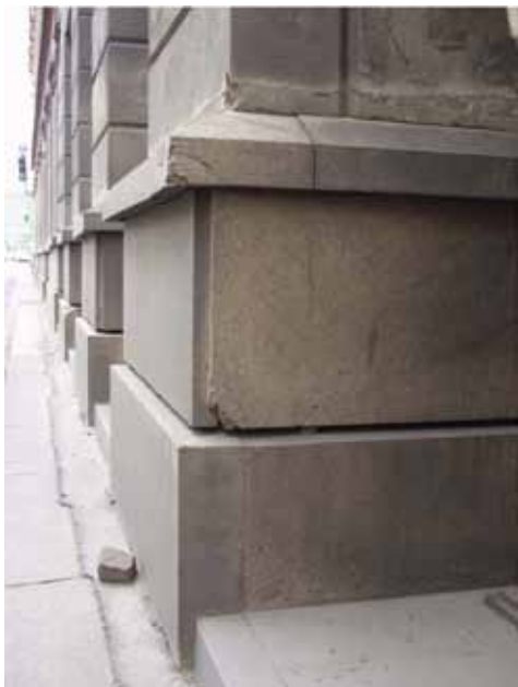
23. fénykép. Élek eltérése a tervezettől (fotó: Szende Árpád)
