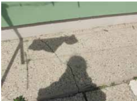
11–12. fényképek. Összetört betonjárda, és betonjárda – előlépcső – lábazat – vakolat megoldatlan csomópontja
