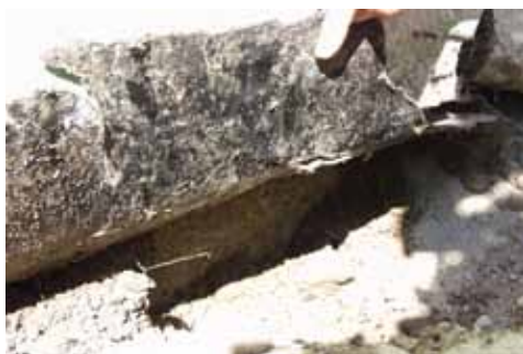
3–4. fénykép. A garázs fala alatti alap-, vízszigetelés 1. jelű feltárása, valamint lábázat és járda hiánya
