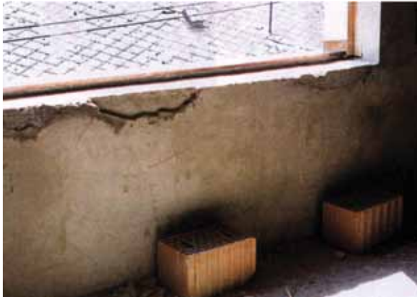
40. fénykép. Utólagos munkavégzéssel, szállítással okozott vakolatleverés nézete (fotó: Szende Árpád)
