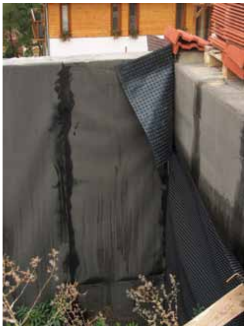
9. fénykép. A drénlemezként alkalmatlan kialakítású felületszivárgó dilatációs elemként választja el a pincefalat a „támfal”-tól.
