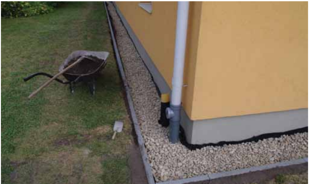
11. fénykép. Kavicsszivárgó építése az épület körül (fotó: TE)
