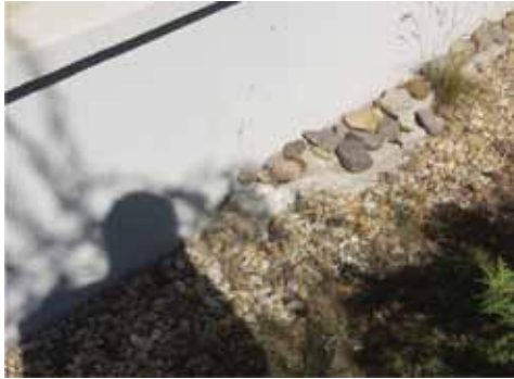
9–10. fénykép. Lábazati betonrepedés, valamint a 2 mm-es habarcsréteg és hiánya
