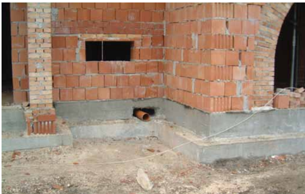
5. fénykép. Építés közbeni felvétel: csak falszigetelés készült (a szerző felvétele)
