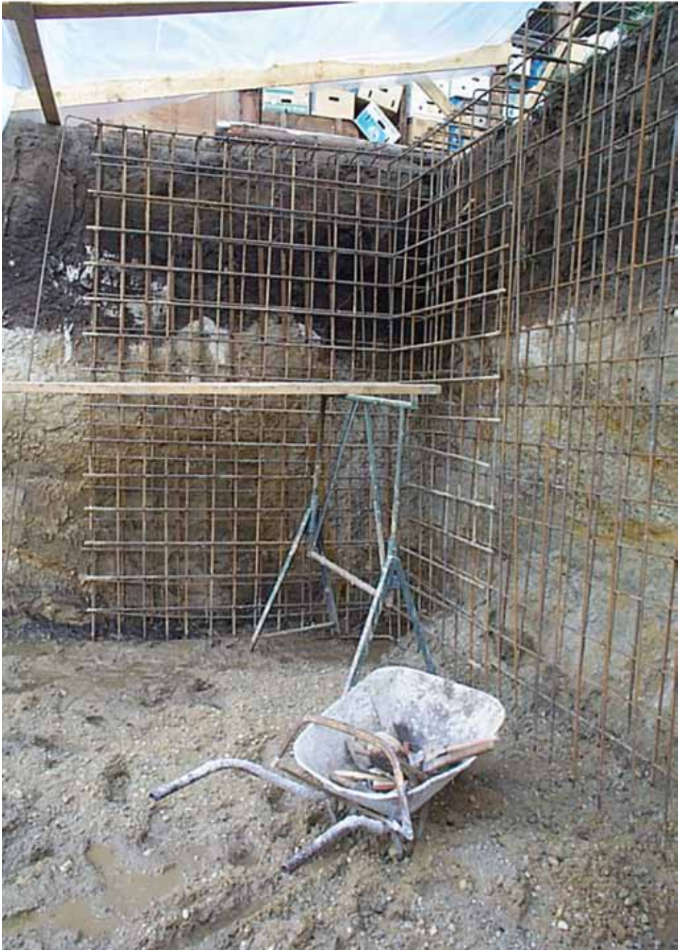
2. fénykép. Félig elkészült vasszerelés a függőleges földfal előtt (fotó: az építető)
