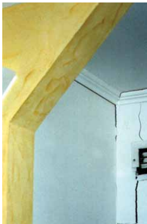
27. fénykép. Az anyagok nem megfelelő használatából (technológiai fegyelem) eredő foltosodási hiba (fotó: Szende Árpád)
