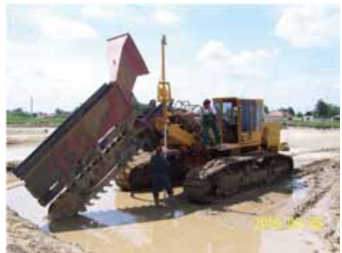
12. fénykép. Dréncsőfektetés talajvízben. 2006. 06. 06.
