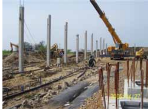
10. fénykép. Szerkezetépítés víztelenítés mellett. 2006. 04. 27.
