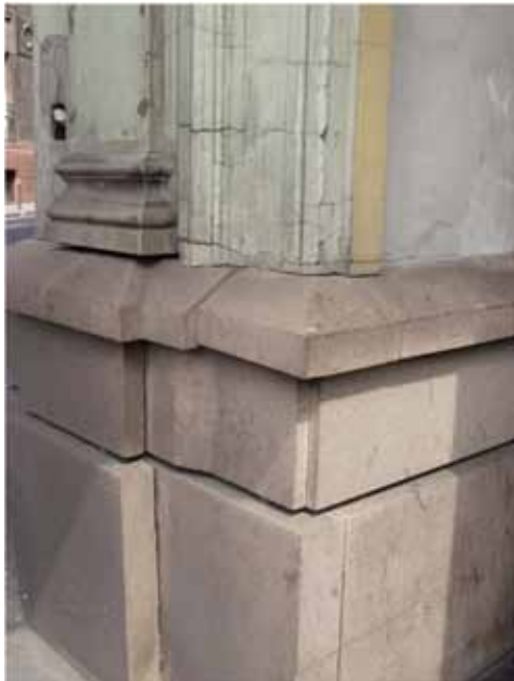
11. fénykép. Állóhézagok nem megfelelő volta (fotó: Szende Árpád)
