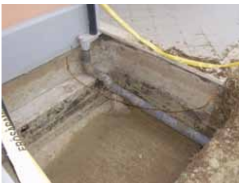
3–4. fénykép. A 2. és 3. jelű feltárás nézetei a törött csatornavezetékkel, a szigetelés hiányával és az A01 lakás teraszával (a szerző felvétele)
