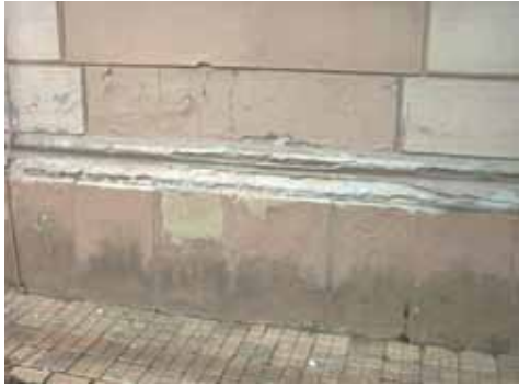
19. fénykép. Lábazati részlet, az íves tagozat utólagos cementhabarcsos kikenésével
