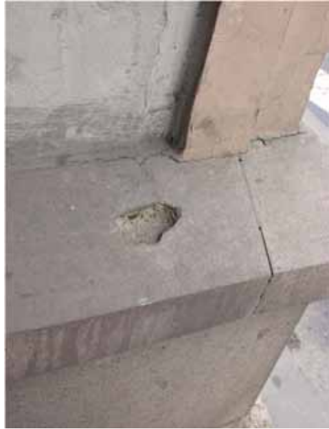
22. fénykép. Agyagzárvány kiesésének nézete (fotó: Szende Árpád)
