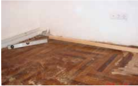
7. fénykép. Eredeti parketta felülete, több cm nagyságrendű eltéréssel a vízszintes síktól
