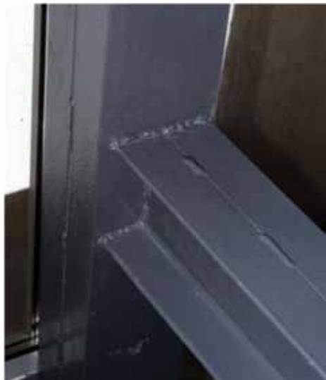
15. fénykép. Leköszörületlen fogadószerkezet acélfelületek, már mázolás után (fotó: Szende Árpád)
