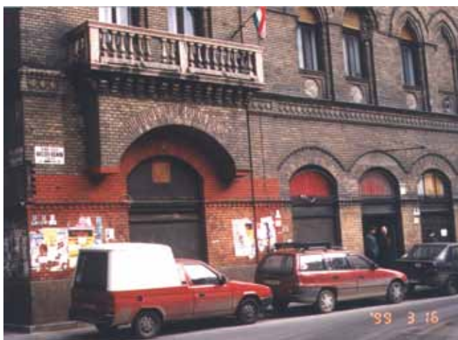
50. fénykép. A jelzőszínek megvédése nem történt meg, ezért a szállítások alkalmával azok megsérültek (fotó: Szende Árpád)
