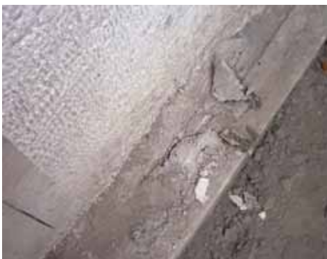
12. fénykép. A pince bitumenes vízszigetelésének lezárása a járda mellett
