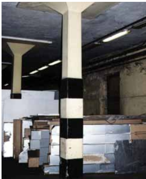
50. fénykép. A jelzőszínek megvédése nem történt meg, ezért a szállítások alkalmával azok megsérültek (fotó: Szende Árpád)
