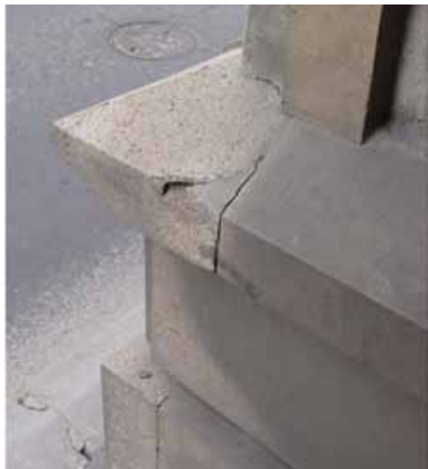
15. fénykép. Idegen anyaggal történő javítás nézete (fotó: Szende Árpád)
