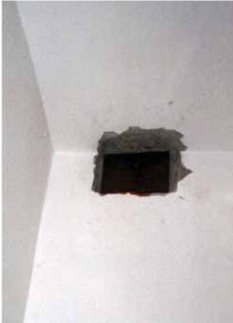
37. fénykép. Utólagosan elhelyezett acélszerelvény okozta belső festési sérülés (fotó: Szende Árpád)
