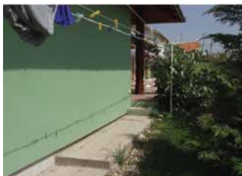
11–12. fényképek. Összetört betonjárda, és betonjárda – előlépcső – lábazat – vakolat megoldatlan csomópontja
