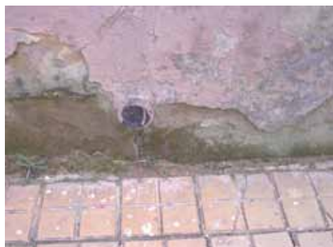
10. fénykép. Lábazat és járda csatlakozása
