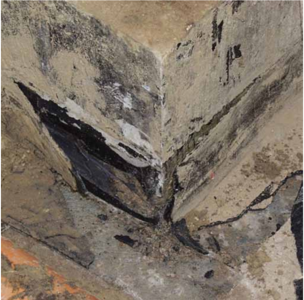
9. fénykép. A szigetelés és toldásának hibái (a szerző felvétele)
