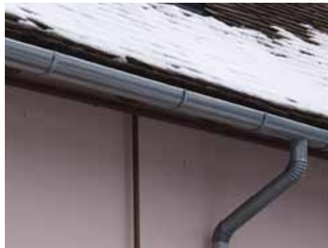
2–3. fényképek. A helyszíni felvételek a kontraajtást és a helytelen csomópontképzést mutatják
