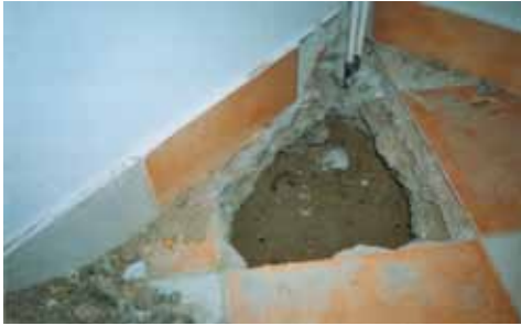
13. fénykép. Hidegburkolatú helyiség az aljzatbeton alatt sötét színű, erősen nedves homokos ágyazattal, vízszigetelés töredezett maradékának nyomaival
