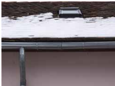
2–3. fényképek. A helyszíni felvételek a kontraajtást és a helytelen csomópontképzést mutatják
