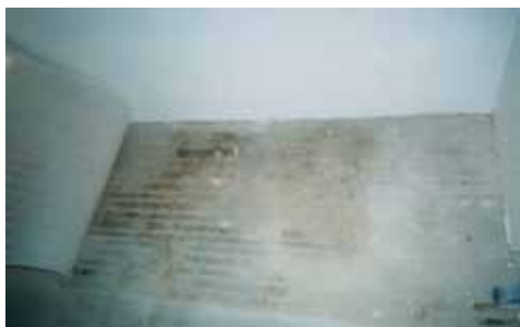
5. fénykép. A régi parkettafelületre ráterített hanglégycső alátét közvetlenül a laminált parketta elbontása után, jól kivehető sötét, vizes foltokkal
