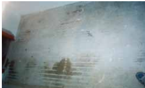
4. fénykép. A régi parkettafelületre ráterített hanglégycső alátét közvetlenül a laminált parketta elbontása után, jól kivehető sötét, vizes foltokkal
