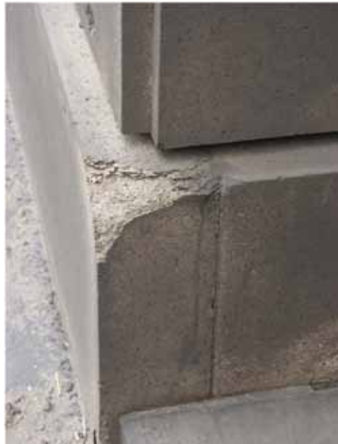
12. fénykép. Állóhézag és sarokkárosodás nézete (fotó: Szende Árpád)
