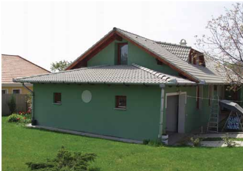
2. fénykép. Az ÉK-i homlokzat nézete garázssal
