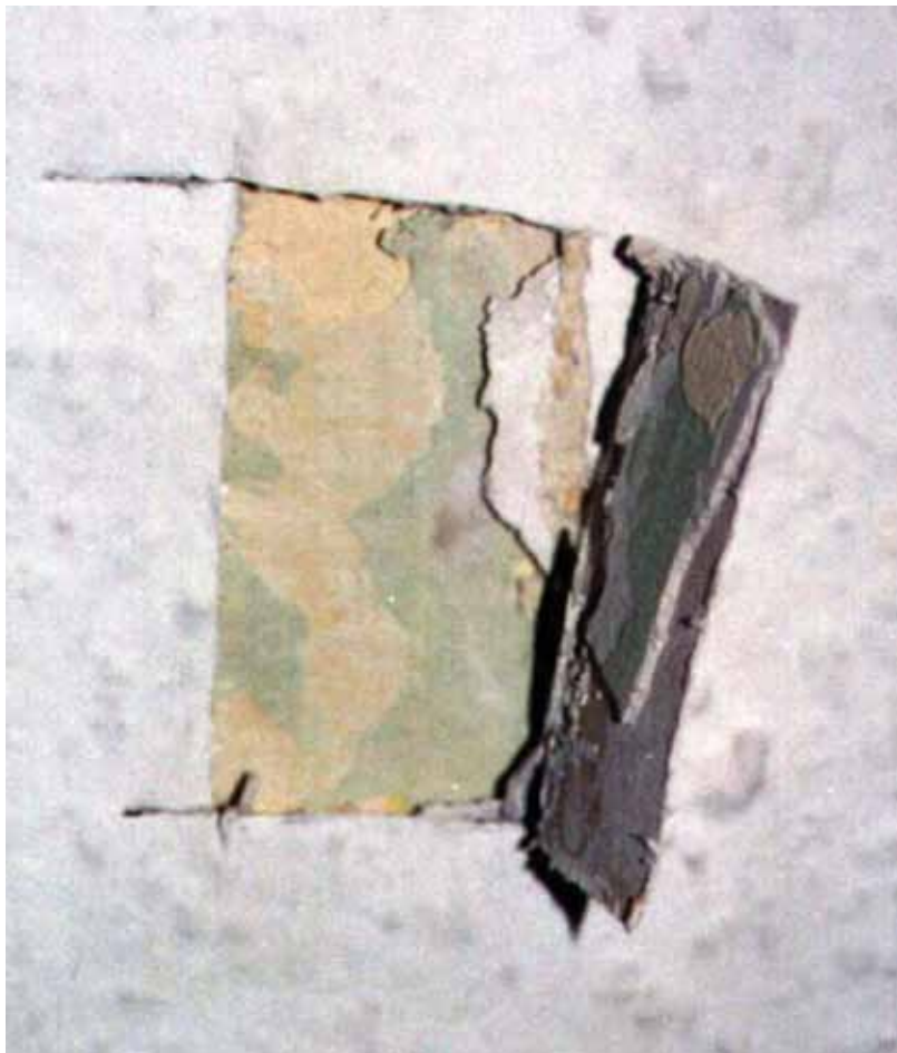
28. fénykép. Az előkészítés [lekaparás (le mosás), felületsimítás] teljes elmaradásának következménye a fűrészporos tapéta és műanyagfestés felválása (fotó: Szende Árpád)
