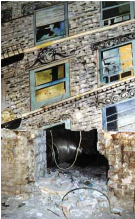
35. fénykép. Seccon, falon átvezetett szellőzővezeték (fotó: Szende Árpád)
