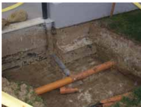
3–4. fénykép. A 2. és 3. jelű feltárás nézetei a törött csatornavezetékkel, a szigetelés hiányával és az A01 lakás teraszával (a szerző felvétele)
