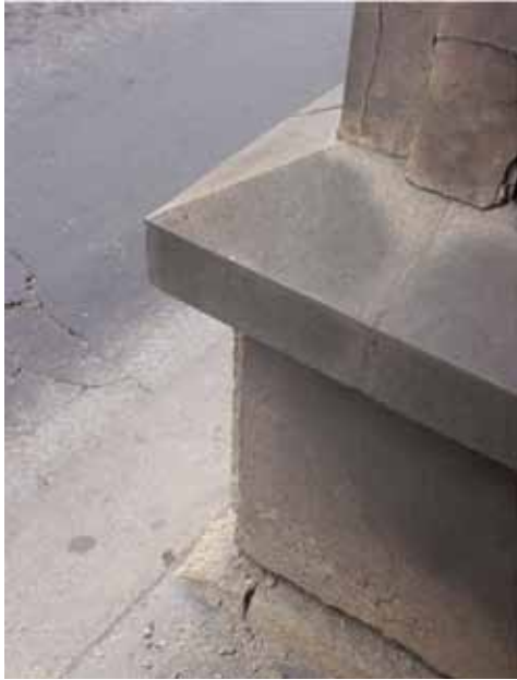
21. fénykép. Kórkorrózió az alsó és középső elemen (fotó: Szende Árpád)
