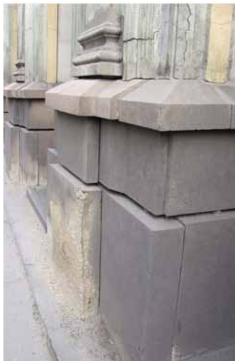
20. fénykép. Elmozdult elemek és korrózió nézete (fotó: Szende Árpád)
