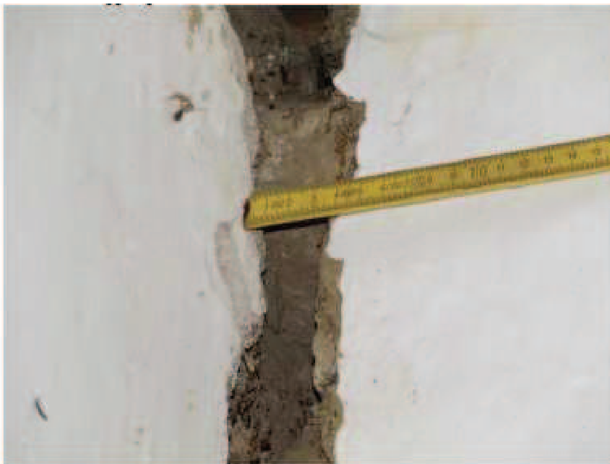
Első szoba – tágasságmérés a süllyedési repedésen (2009.09.13.) nőtt a tágasság (45 mm)
