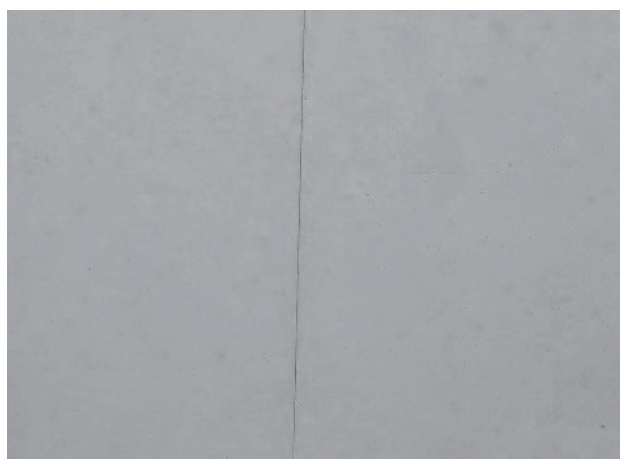
Dokaplex tömített zsaluhéjillesztés betonképe
