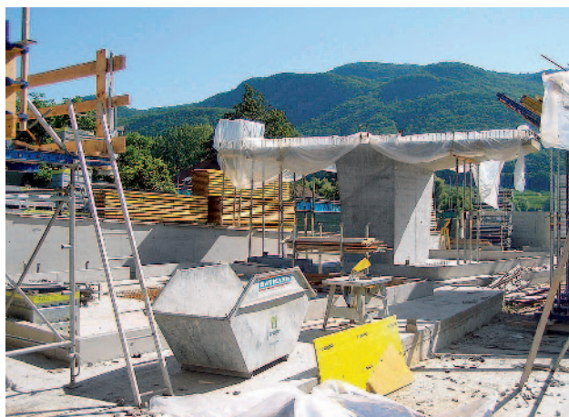
A csatlakozó vasszerelés védelme
