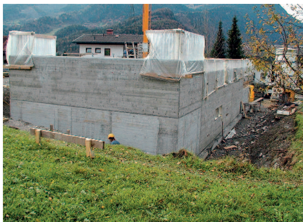
A csatlakozó vasszerelés védelme
