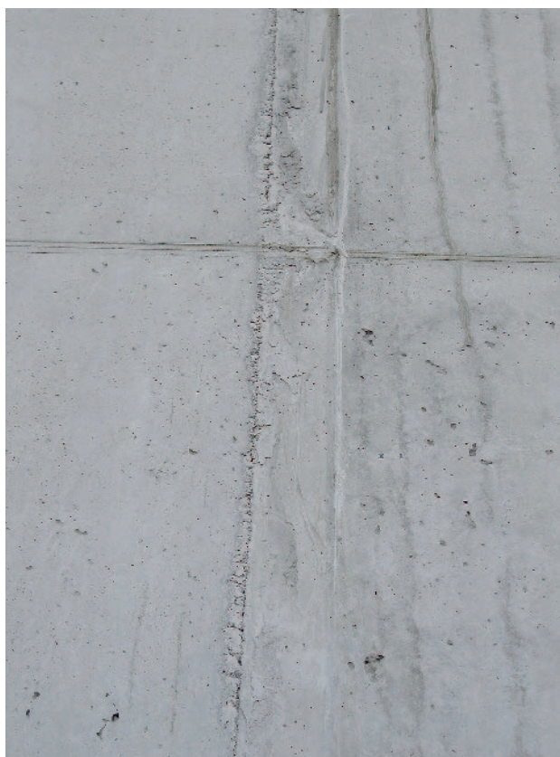
Munkahézag tömítőszalag nélkül
