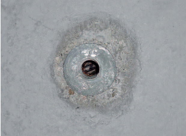
"Kivérzés" a nem tömített ankerhely esetében
