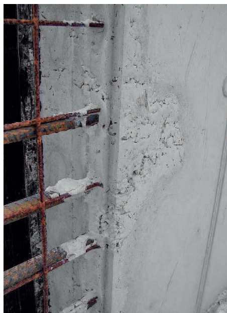
Példa: Tömítetlen véglezárás zsaluzata
