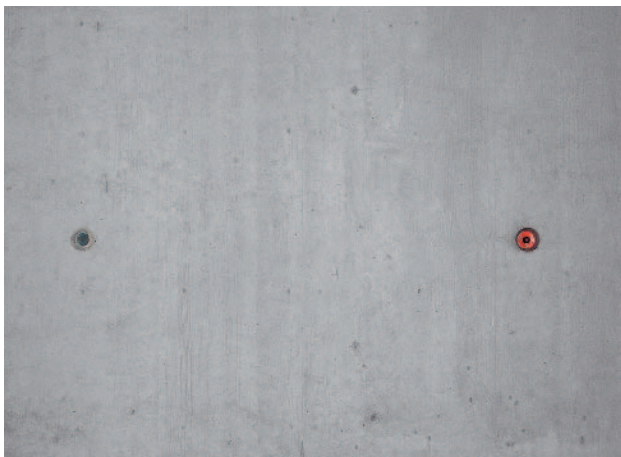
Egységes lyukkép (ankerhely - felfüggesztési pont)
