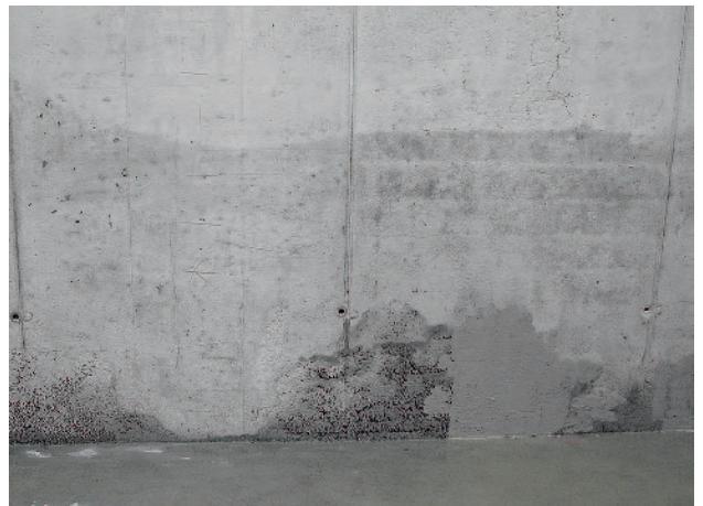
Eredmény tömítőzsinór nélkül
