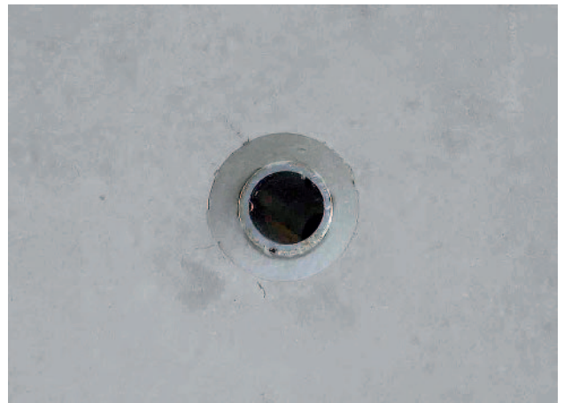
Tömített ankerhely kivérzések és kitörések nélkül
