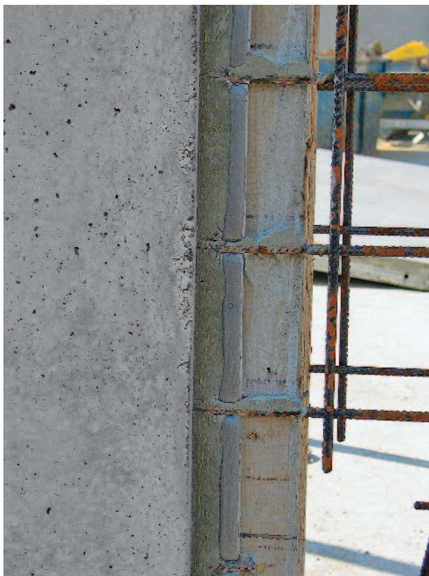
Véglezárás zsaluzata tömítőszinórral
