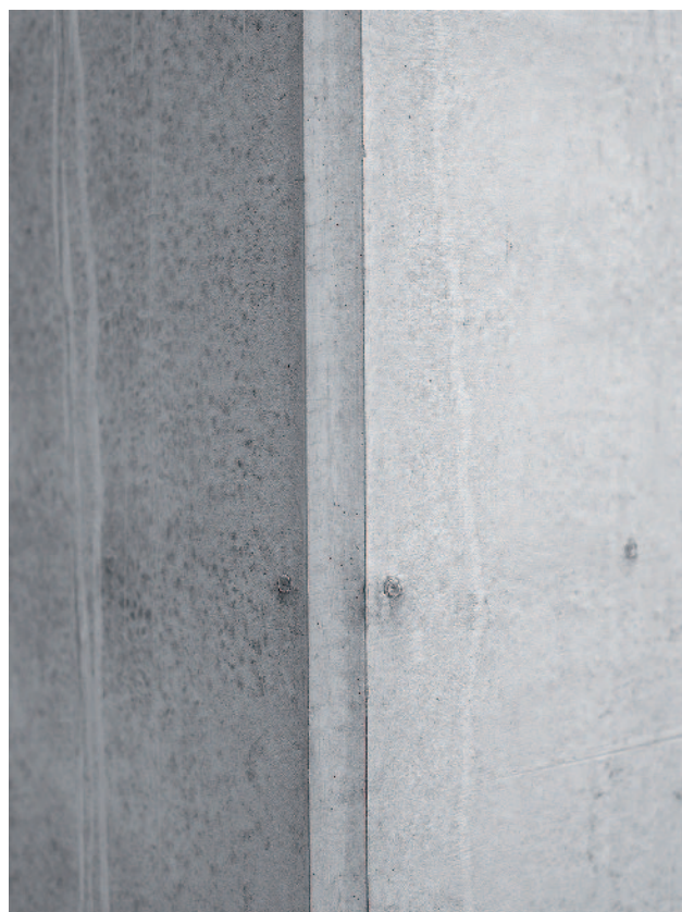
Sarok kialakítása élképzővel
