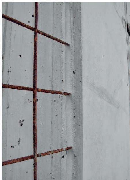
Példa: Tömített véglezárás zsaluzata
