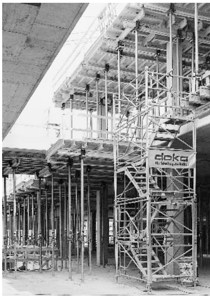
Építkezés: ARCE Nyugat-Münster centrum, Bocholt
