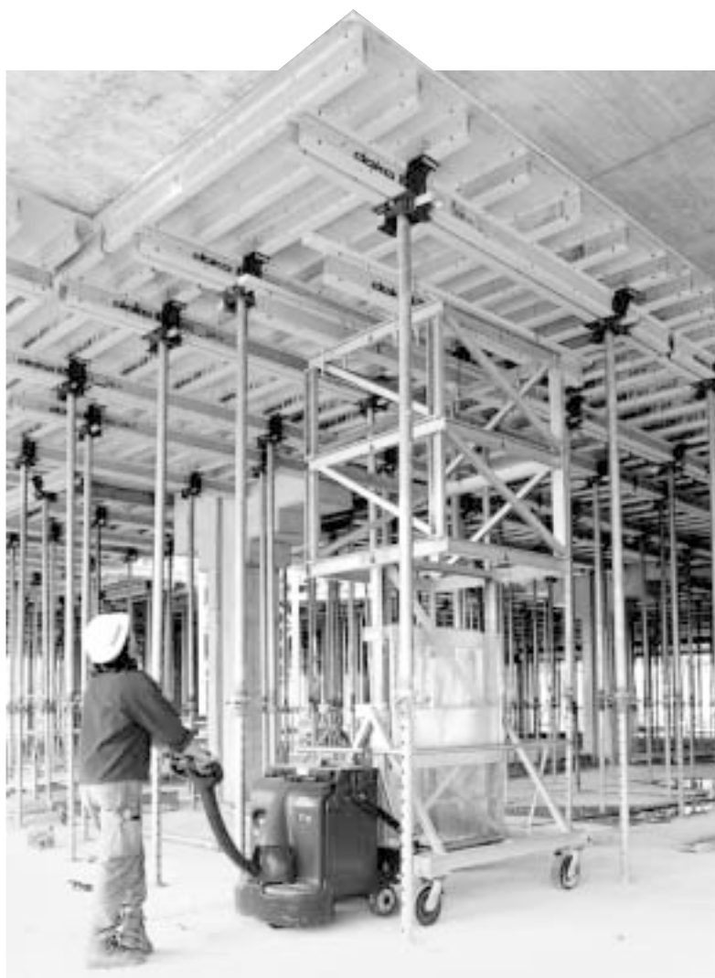
Építkezés: ARGE Plus – City 2000 Pasching
