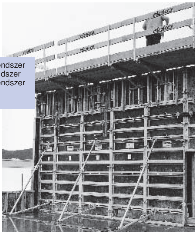
Építkezés: Közigazgatási épület Multring, Weinheim
