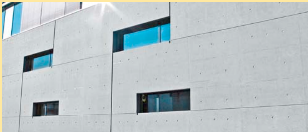
A Doka OptiX gátolja a pórusképződést hozzájárulva ezzel a minőségi betonfelületek előállításához.
