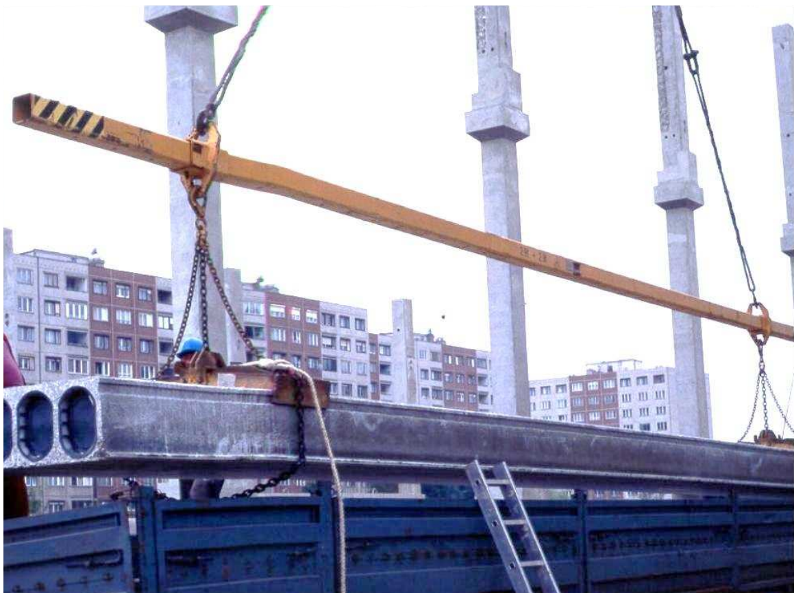
Megfogás szorítópofákkal – előre kialakított horonyban ( tényleges megfogási pont nélkül )
