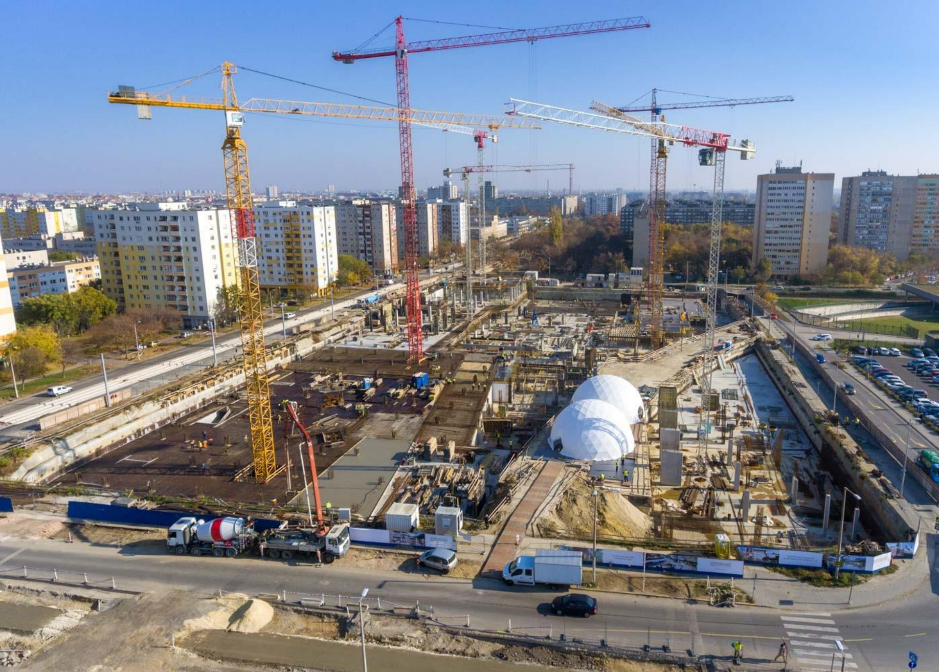
Source: www.magyarépitok.hu / Budapest, Kelenföld – Etele plaza construction, 2018
