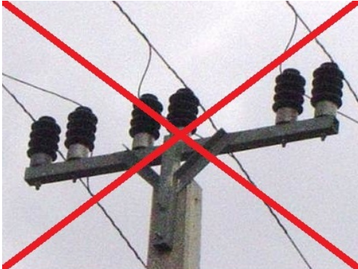
Szűkített fázistávolságú egysíkú keresztartó (VÁT-H20)
