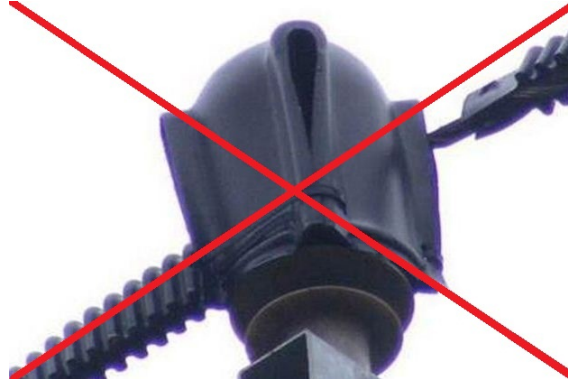
Madárvédő burkolat (szigetelőre). Összes eddig használt típus letiltásra került.
