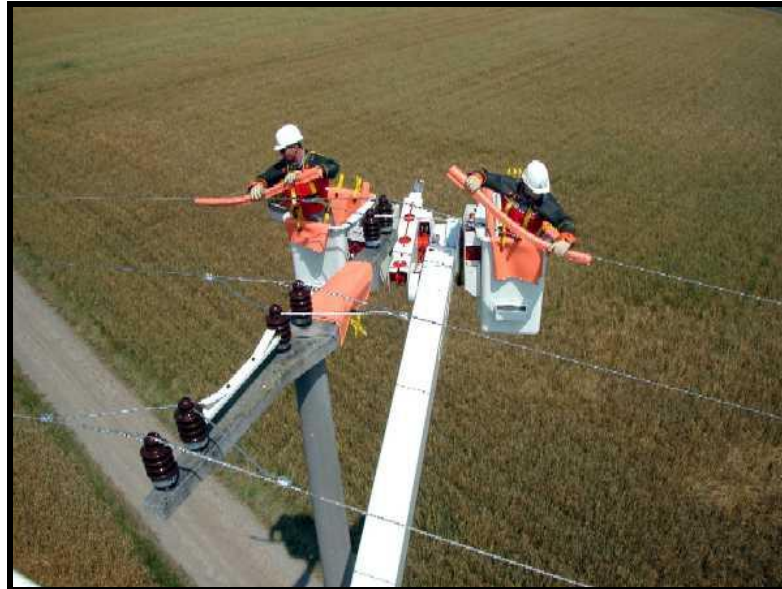
Munkavégzés szigetelő kesztyűvel
